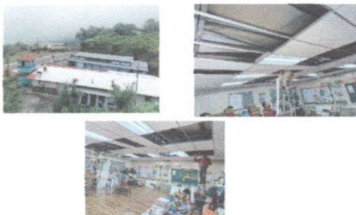
MANTENIMIENTO DE TECHO
