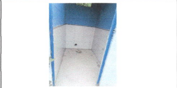
REPARACION Y SUSTITUCION DE AZULEJO
